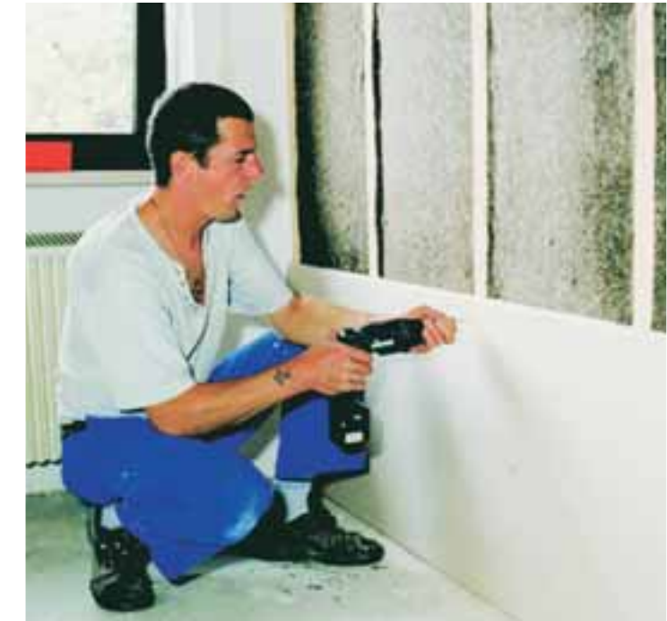
27 Schadstoffsanierung mit Spezial-Schaf- wollvlies (Doppelmayer)
