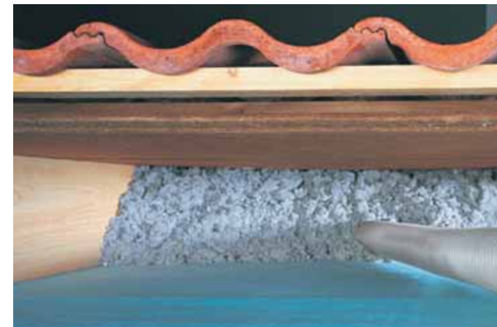
22 Einblasen von Zellulosedämmstoff
