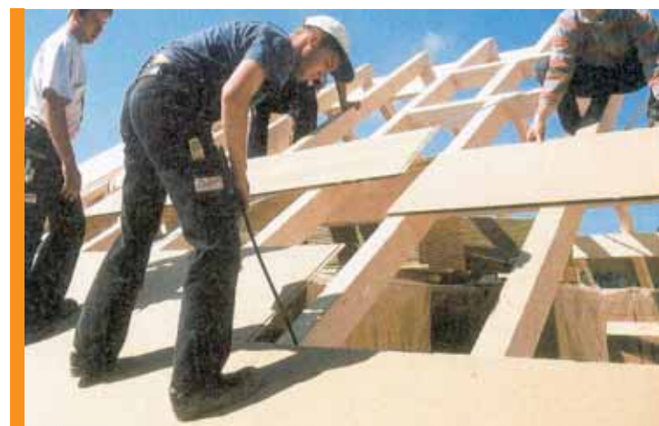
26 Aufsparren- dämmsystem (Natur-Baustoffbuch)
