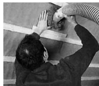
32 In den vorbereiteten Dachhohlraum wird Zellulose-Dämmstoff von innen oder außen eingeblasen (isofloc)
