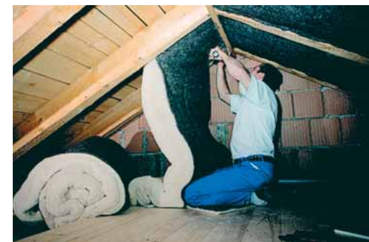
31 Zwischensparrendämmung mit Schafwolle (Doppelmayer)
