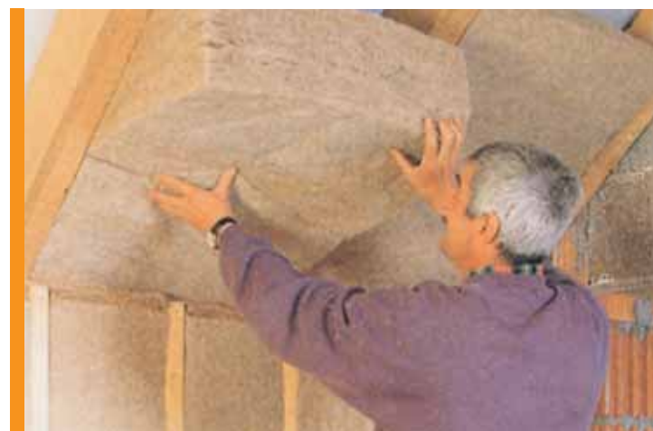
28 Zwischensparren- dämmung mit Hanf- matten (Hock)
