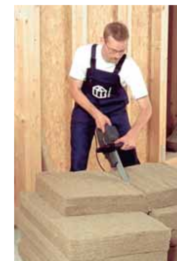
27 Zuschnitt von Flachsdämmmatten (Flachshaus)
