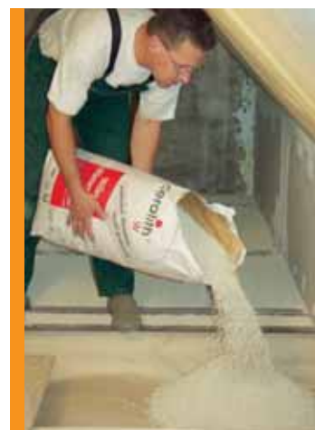
30 Schüttdämmung mit dem Roggendämmstoff Ceralith W (Romonta Ceralith)
