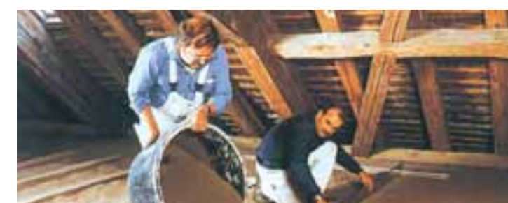
3 Trockenschüttungen mit Höhenausgleich (Knauf-Bodensysteme 2001)
