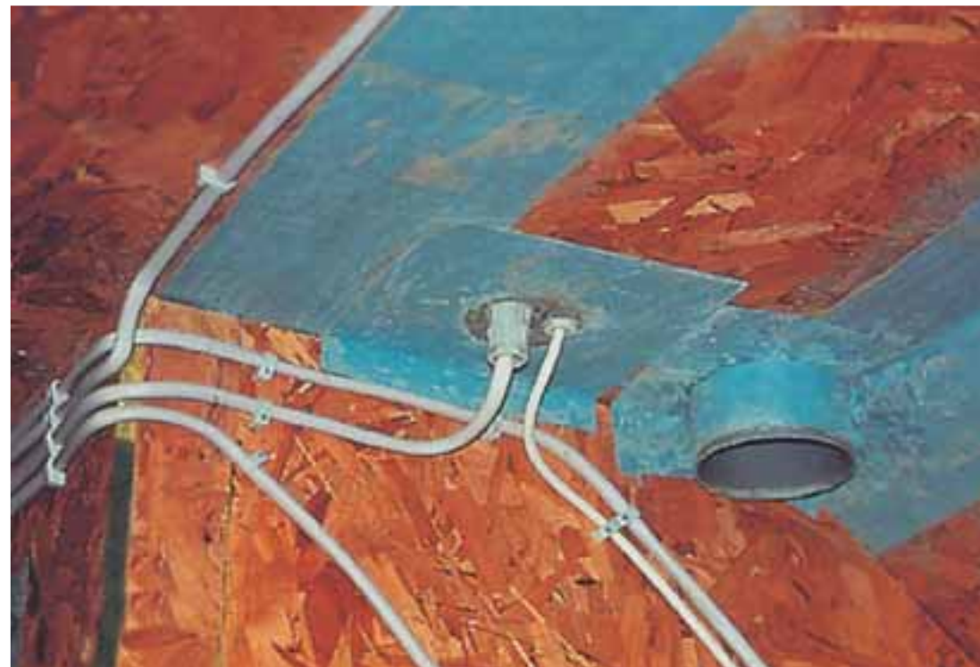
21 Vorbildlich ausgeführte Durchführungen – sie wurden auf einer Werkbank vormontiert und dann fertig eingebaut! (quadriga, 1/2001)
