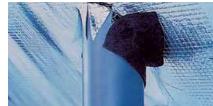
17 Ablebung des Dichtungsflickens mit hochdehnfähigen Butyl-Band (quadriga, 1/2001)
