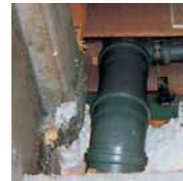
11 Freier Blick (= freier Weg für Kaltlufteintritt) in Installationswand aus dem Keller. (quadriga, 1/2001)
