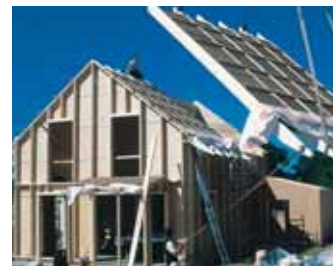
Wirtschaftliches Bauen durch moderne Holzbauweisen.
